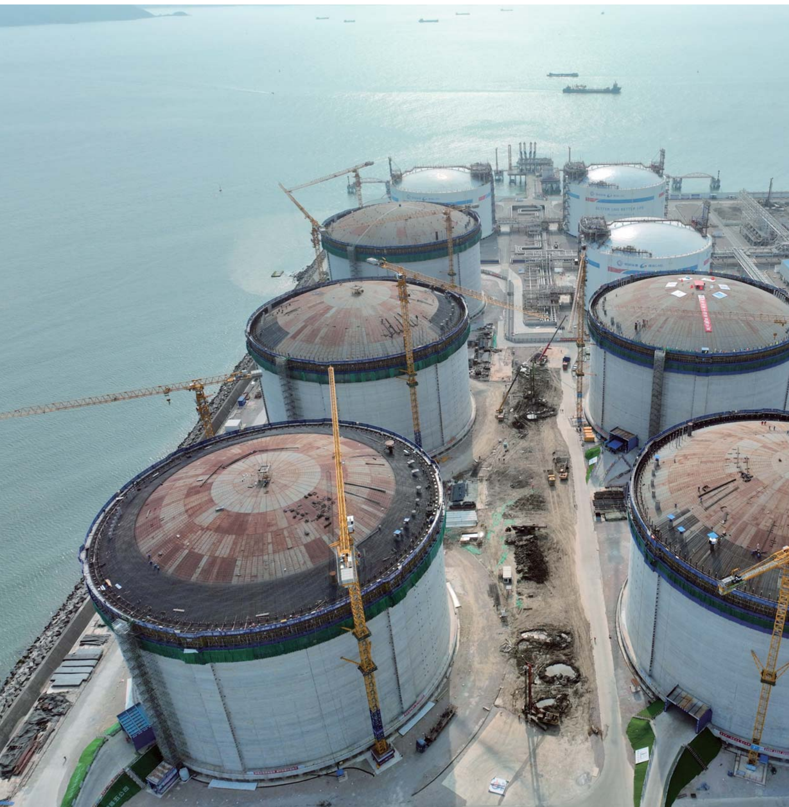
□ 广东珠海 LNG 扩建项目二期工程项目 建造现场
