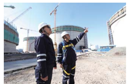
□ 唐山 LNG 项目接收站二期工程项目
