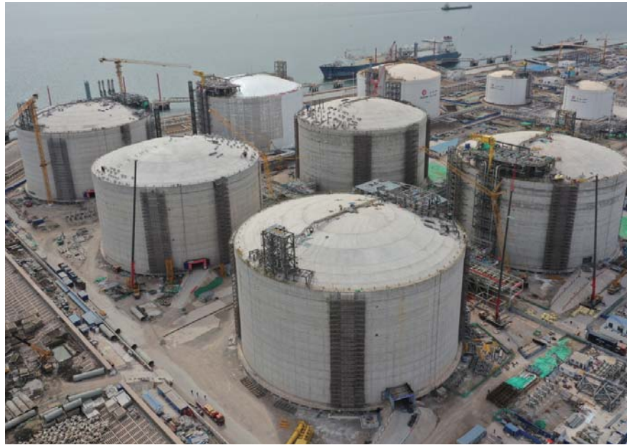
□ 天津 LNG 二期接收站工程项目
