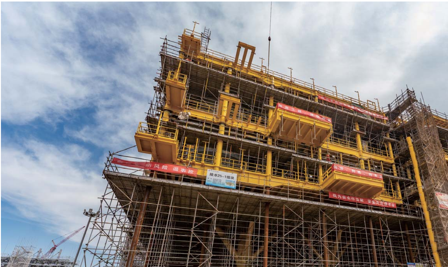
□ “深海一号”二期工程项目组块陆地建造现场
