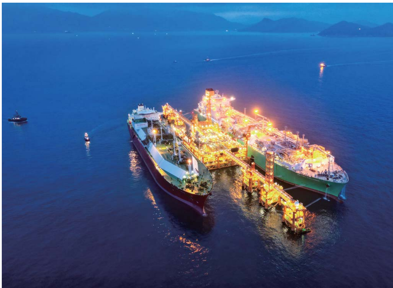
□ 全球最大海上液化天然气接收站——香港 LNG 接收站项目完工交付
