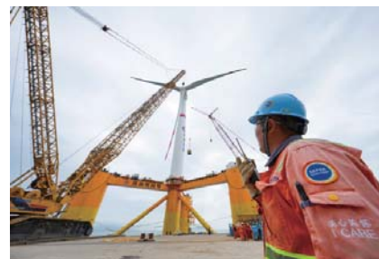
“海油观澜号”总装现场
