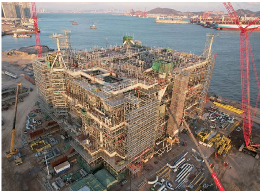
□ 马赞项目陆地建造现场
