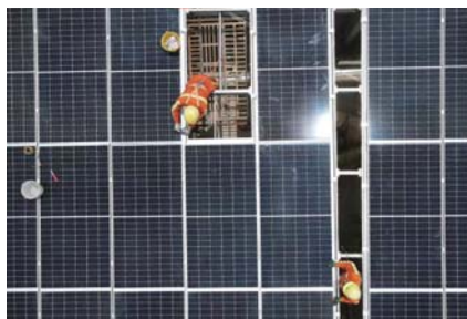
□ 光伏现场施工
