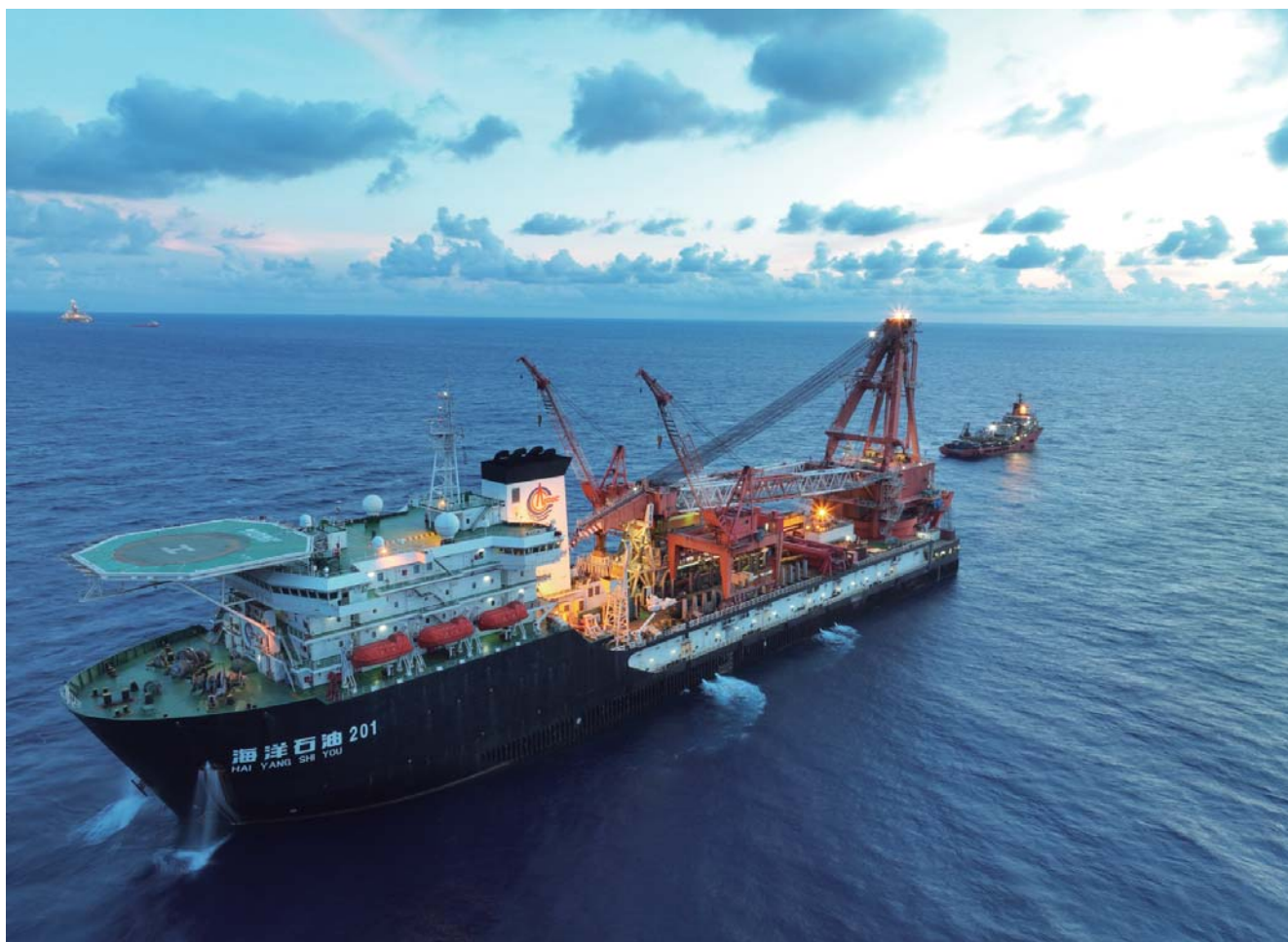
深海一号二期陵水 25-1 项目 海管铺设
